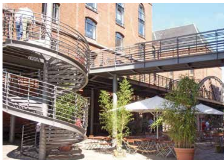
Passerelle piétonne à Rotterdam.
